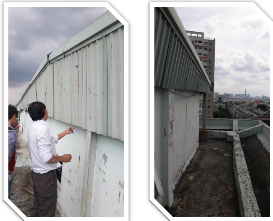
Hình 10: Nhóm NCKH cùng với GVHD tiến hành khảo sát mái nhà khu D của trường
